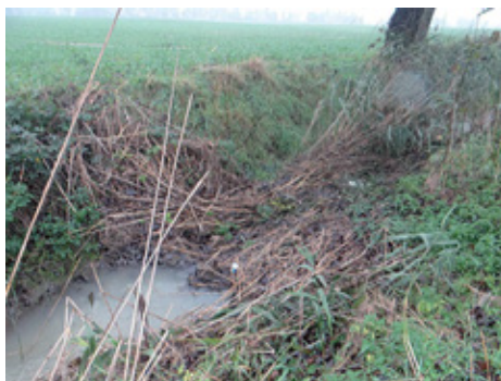
Ryc. 53. Zator z liści i sitowia na rowie przydrożnym
